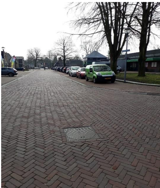
Oude Asserstraat, parkeren op trottoir
