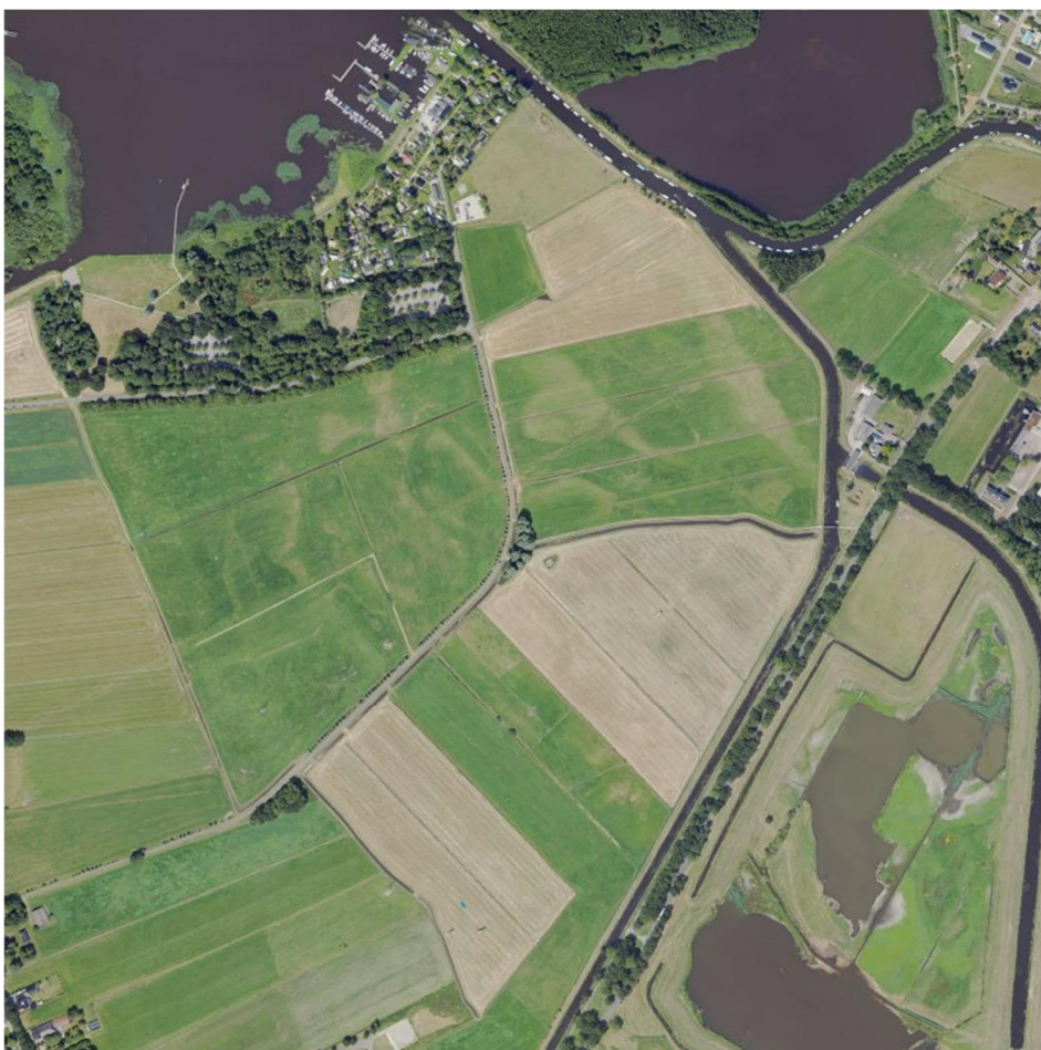
Figuur 3-1 Luchtfoto plangebied, opnamedatum 19-07-2022 (bron: Cyclomedia ©)
