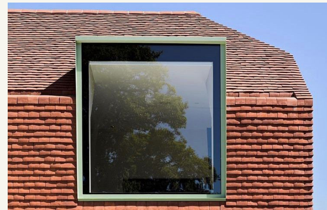
Dakkapel geïntegreerd in de gevel
