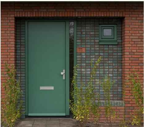
Verschillende baksteenverbanden
