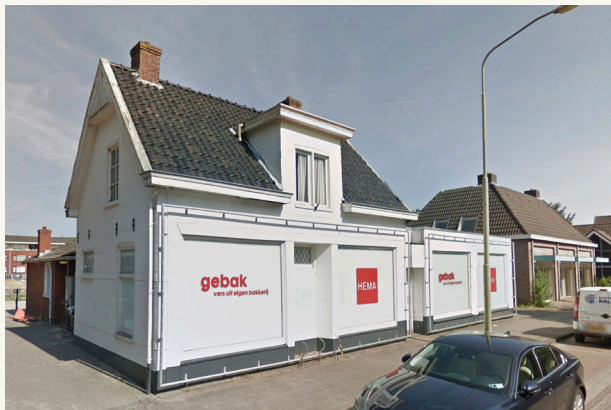
Referentie naar oorspronkelijke bebouwing
