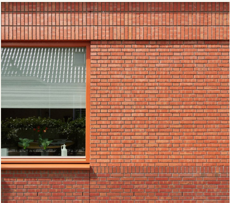
Verschillende baksteenverbanden
