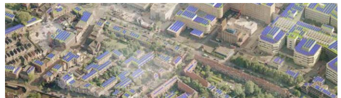
Stedelijke daken bieden ruimte voor energieopwekking.
