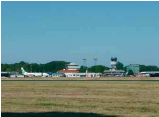
Baanverlenging en uitbreiding
