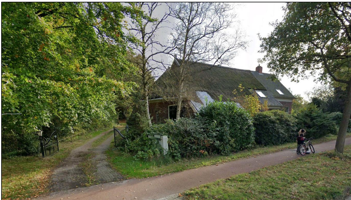
Entree van het plangebied aan de Paterswoldseweg. Rechts van de entree bevindt zich de dienstwoning.
