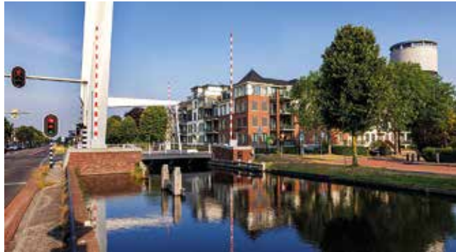
DE WITTERBRUG IN ASSEN
