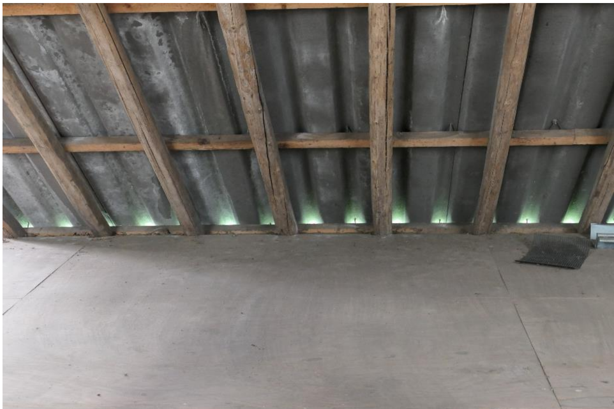
Figuur 4.8 Openingen in de dakrand geeft toegang voor vleermuizen
