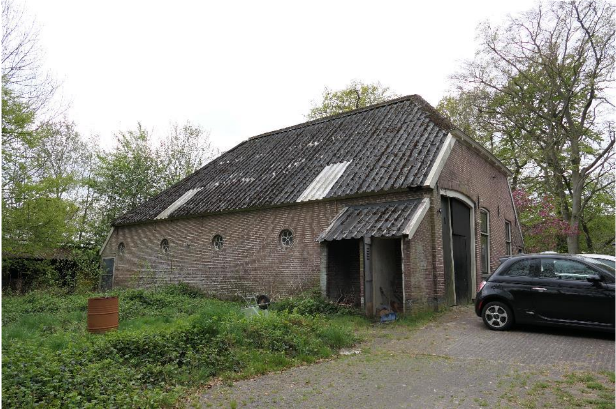
Figuur 1.5 De te slopen schuur.
