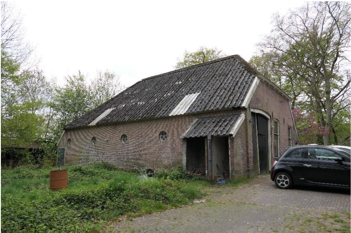
Figuur 2.5 De te slopen schuur.
