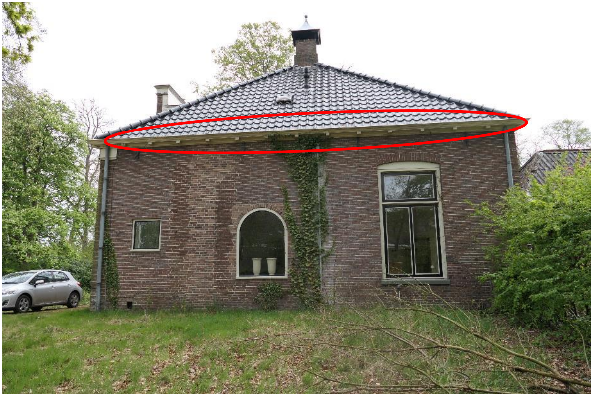
Figuur 4.4 Potentiële nestplaatsen van huismussen bevinden zich onder de eerste rij dakpannen (rood omcirkeld).
