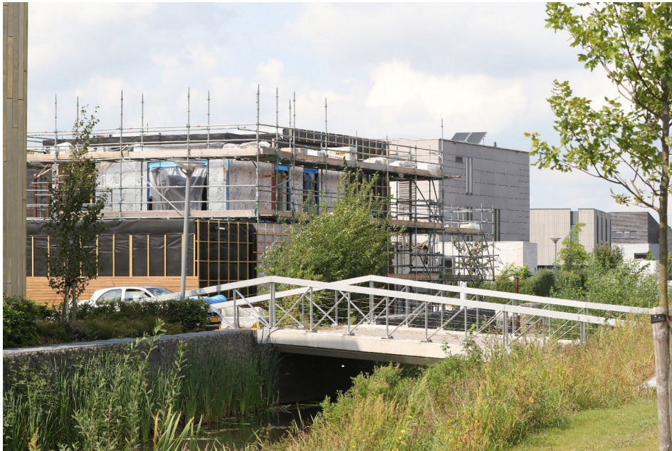
Woningen in aanbouw in Ter Borch
