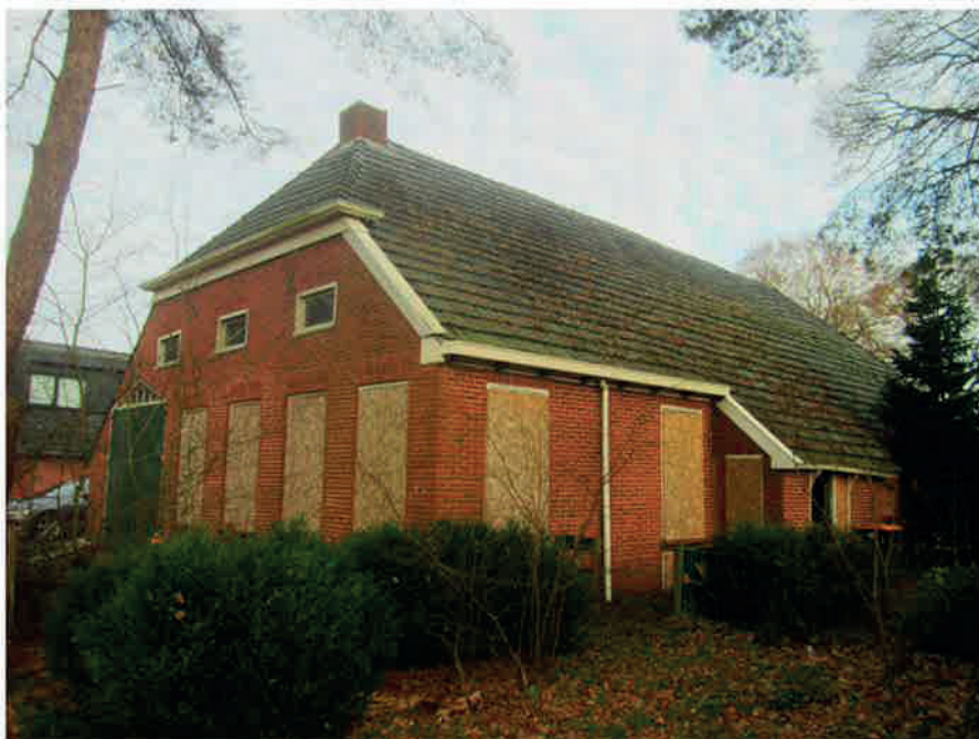
Foto 14, Overzichtsfoto van de buitenzijde van de asbestvrije boerderij.
