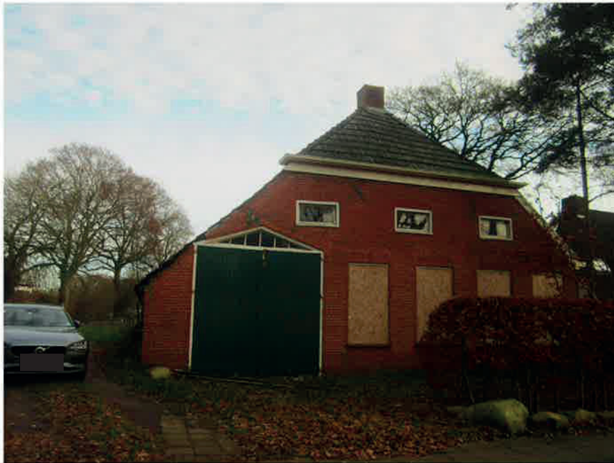
Foto 13, Overzichtsfoto van de buitenzijde van de asbestvrije boerderij.
