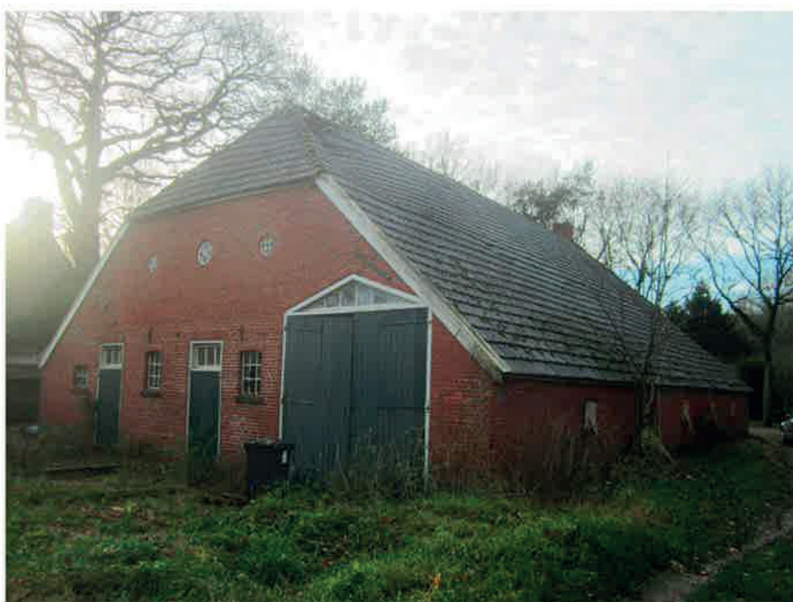
Foto 12, Overzichtsfoto van de buitenzijde van de asbestvrije boerderij.
