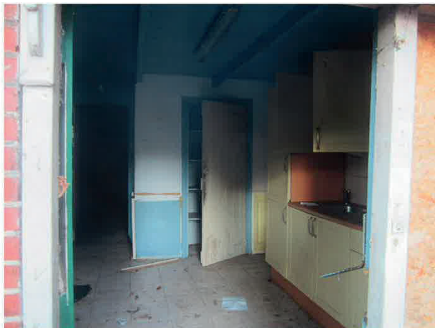
Foto 5, Overzichtsfoto van de asbestvrije keuken.
