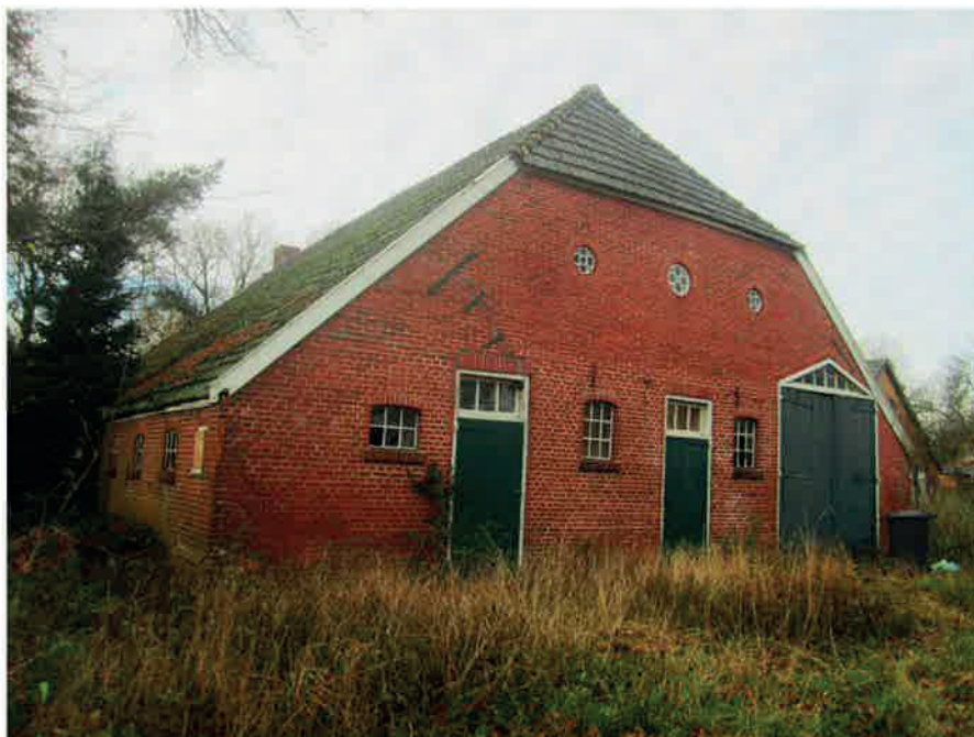
Foto 11, Overzichtsfoto van de buitenzijde van de asbestvrije boerderij.
