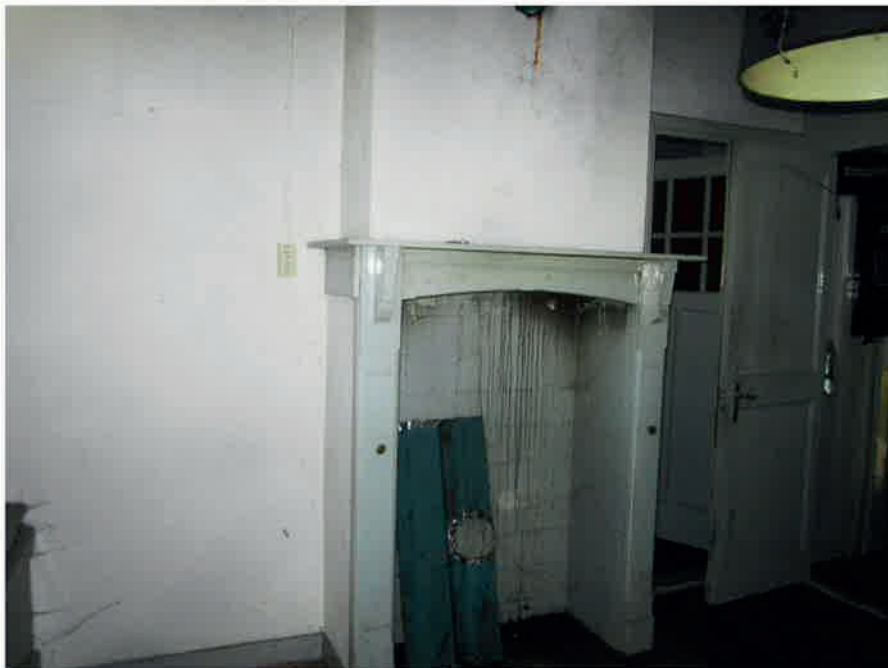
Foto 2, Overzichtsfoto van de asbestvrije schouw met opgemetselde rookgasafvoer in de eetkamer.
