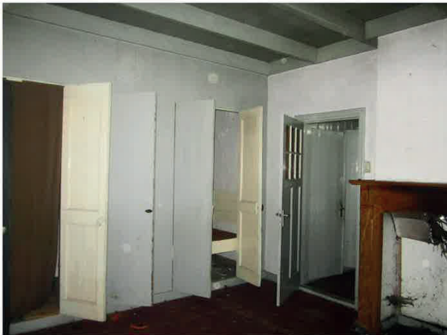
Foto 4, Overzichtsfoto van de asbestvrije woonkamer met bedsteden en asbestvrije schouw met opgemetselde rookgasafvoer.
