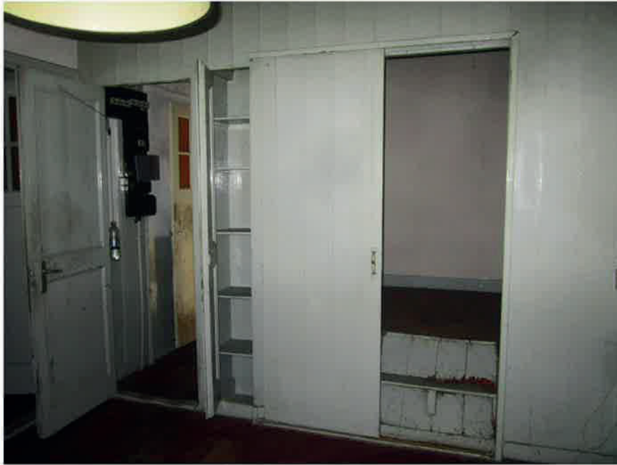
Foto 1, Overzichtsfoto van de asbestvrije eetkamer met opkamer en ondergelegen kelder.
