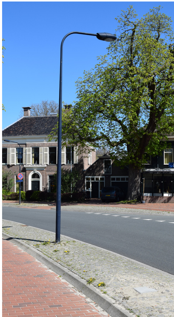
Verlichting langs de rijbaan
