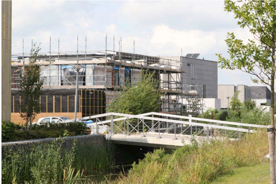
Woningen in aanbouw in Ter Borch
