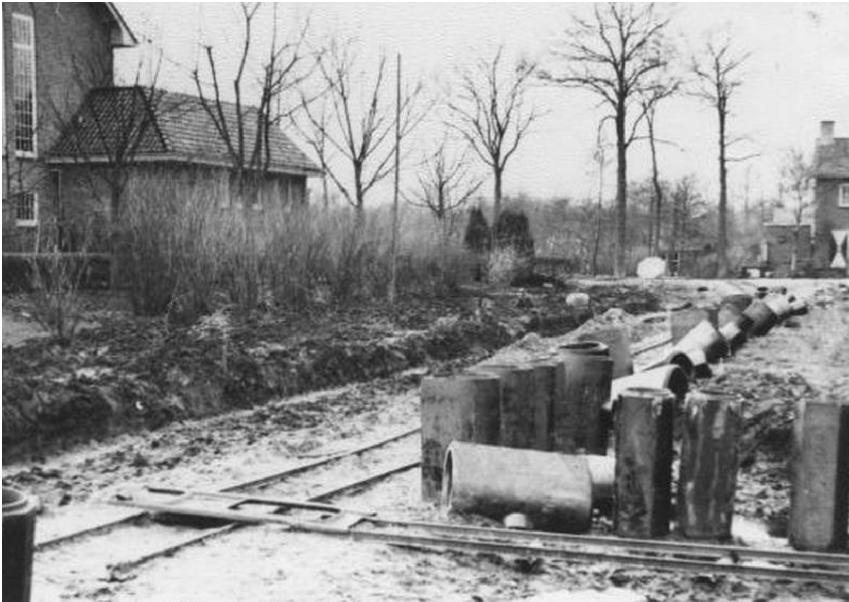
Aanleg riool Oranjelaan, foto van Oal Eel.
