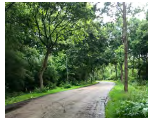
Toegangsweg Hanekamp, 6,5m. breed
