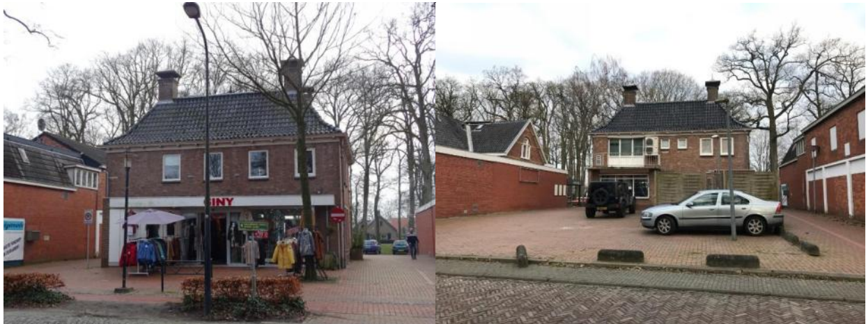
Zicht op voor- en achterzijde van het pand en omliggende erfverharding.
