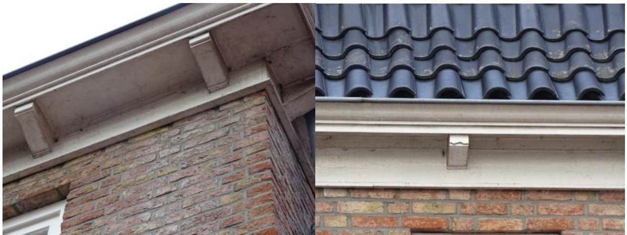
Linkerfoto: spleten tussen houtwerk en bakstenen muur van de gevels. Rechterfoto: dakpannen met dakgoot en ruimte onder pannen.
