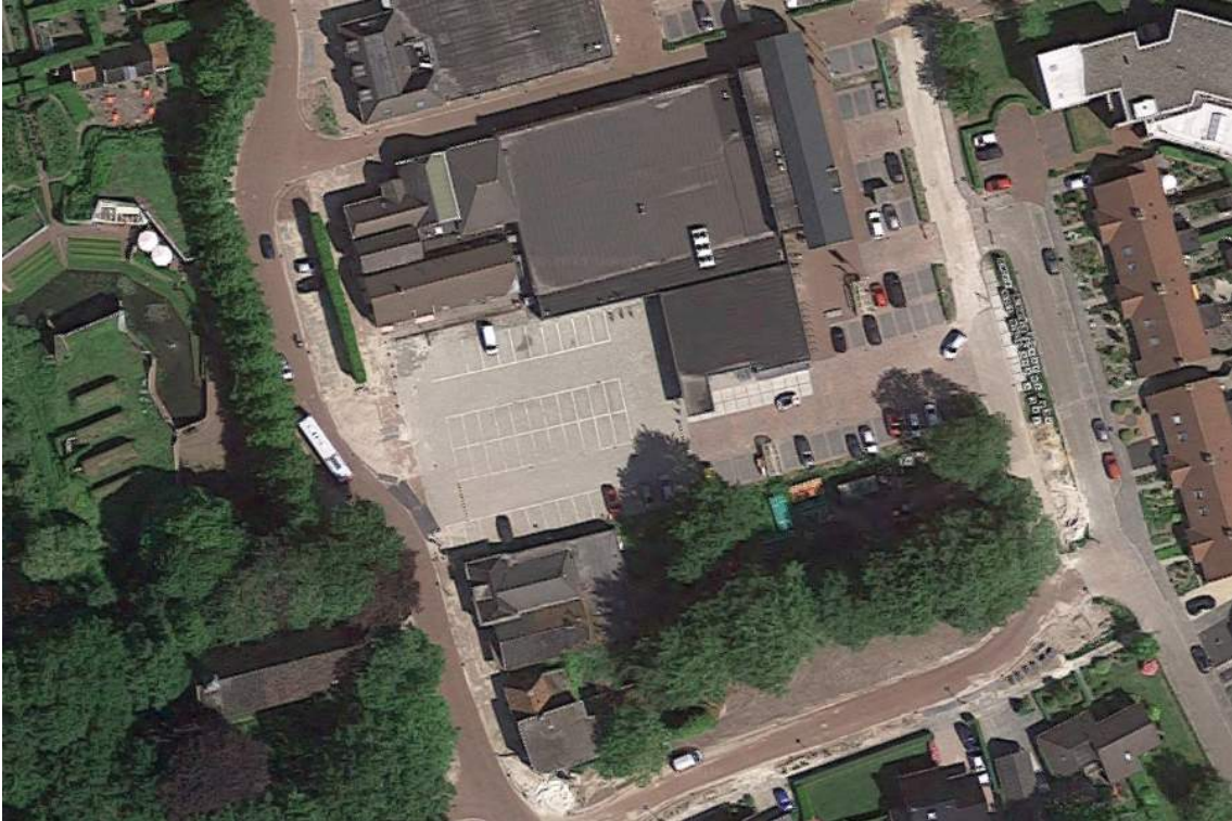
Figuur 2.2 Luchtfoto van de huidige situatie in het plangebied
