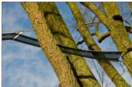
Detail van eekhoornbrug
