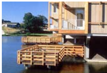
houtskeletbouw met natureltinten
