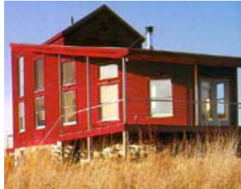
hout geverfd in kleur roodbruin (Rietwoningen)
