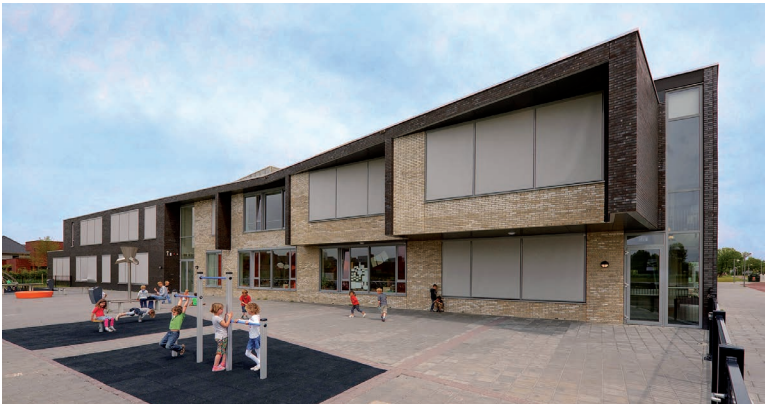
Multifunctionele Accommodatie (MFA) Borchkwartier
