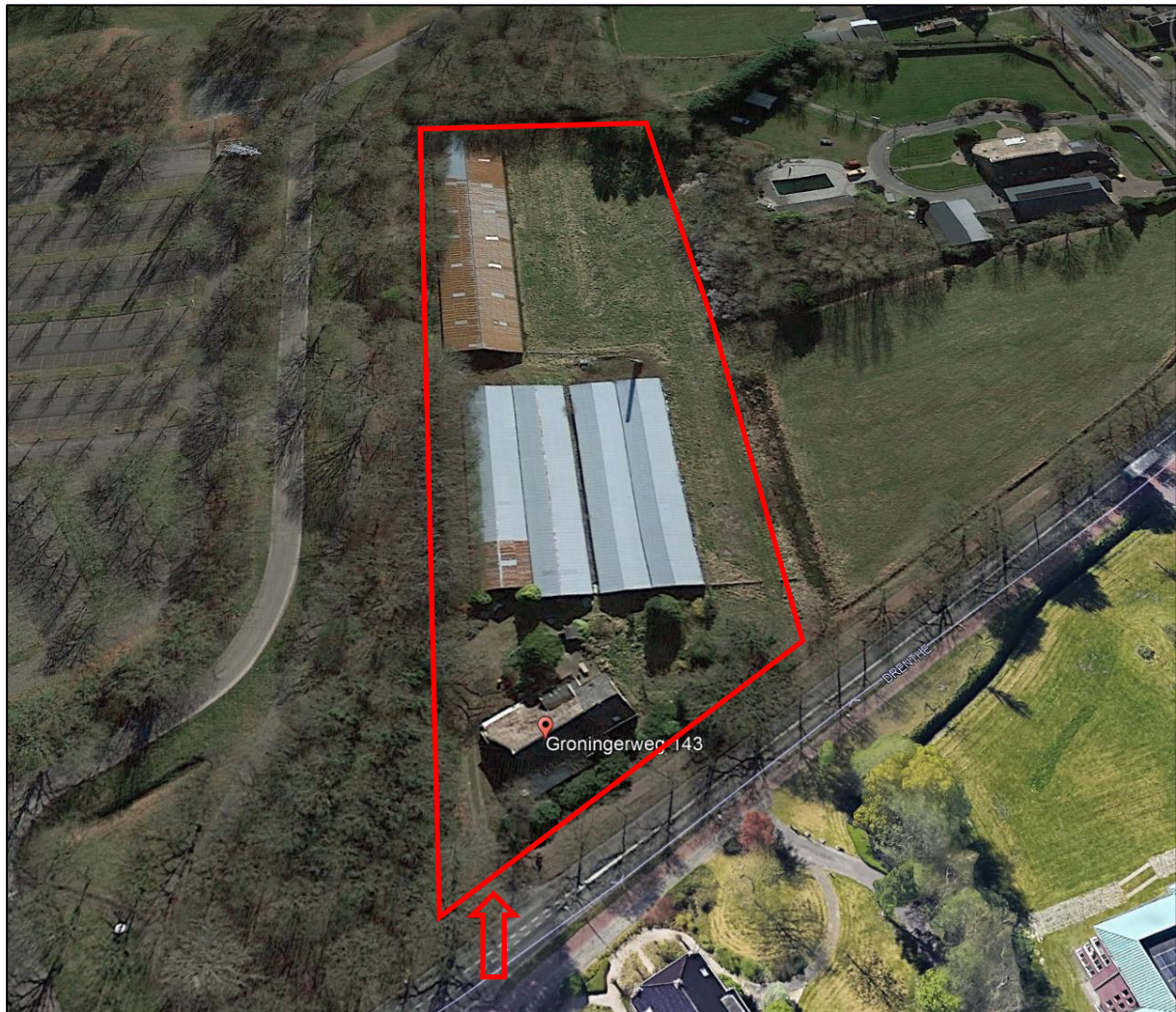
Bestaande bebouwing binnen het plangebied.
