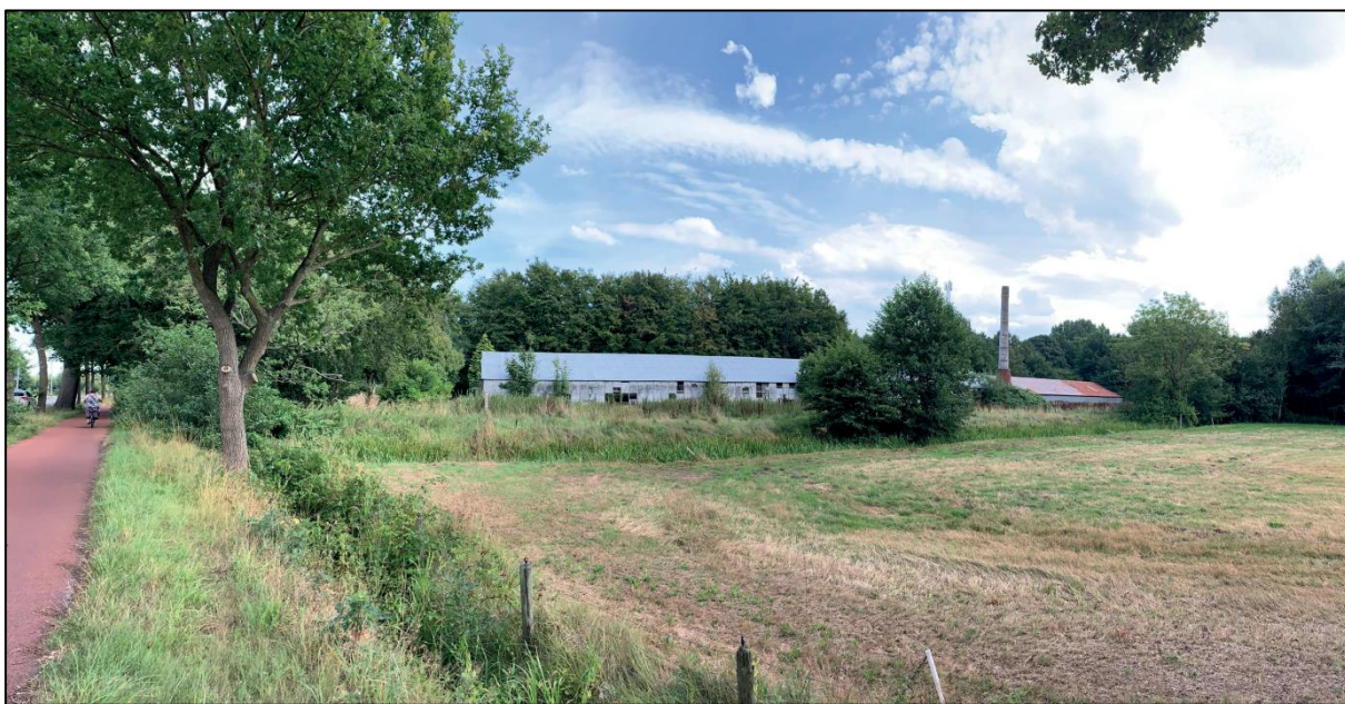
Zicht op de bestaande bedrijfsbebouwing vanaf de Paterswoldseweg.
